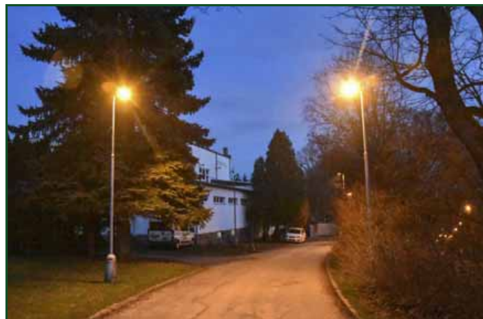
▲ Veřejné osvětlení v Husově ulici. Foto: Michael Omes
