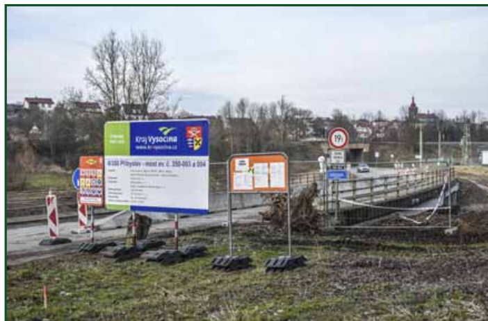
▲ Most přes řeku Sázavu před rekonstrukcí.
