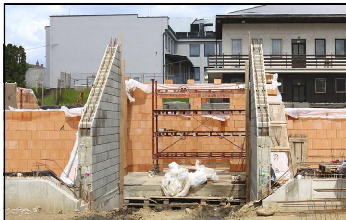
Stavba nové tribuny na stadionu. Foto Ivo Havlík
