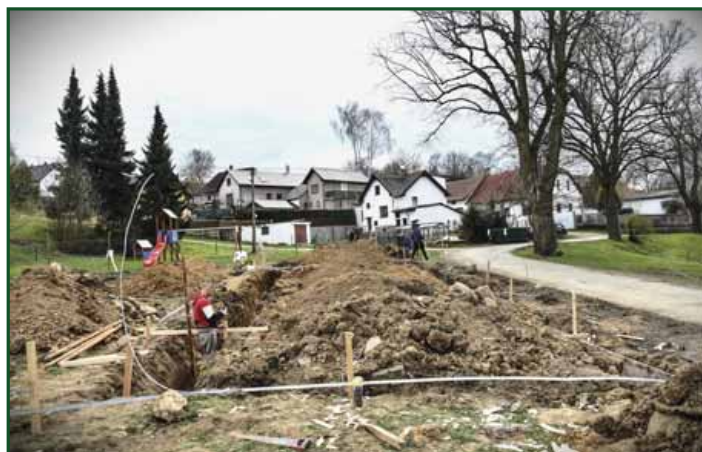
▲ Budování základů pro zázemí víceúčelového sportoviště v Poříčí u Přibyslavi. Foto: Michael Omes
