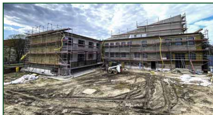
▲ Zateplení a rekonstrukce kulturního domu v Přibyslavi – duben 2023. Foto: Michael Omes
