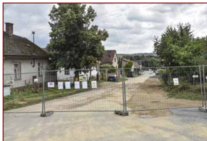
▲ Uzavřená Rašínova ulice z důvodu rekonstrukce, srpen 2022. Foto: Michael Omes
