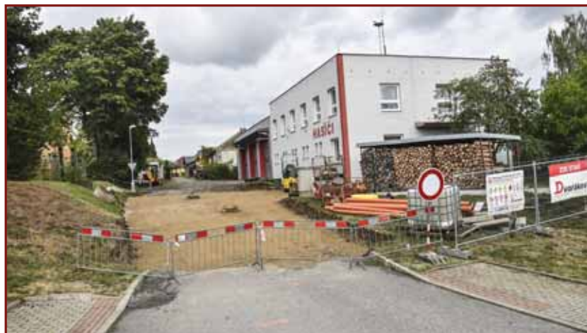
▲ Rekonstrukce ulice Hasičská. Foto: Michael Omes
