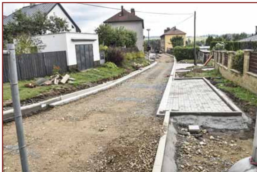
▲ Rekonstrukce ulice Pelikánova. Foto: Michael Omes
