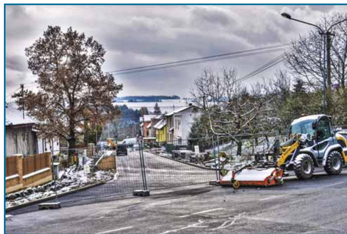
▲ Rekonstrukce ulice Rašínova - listopad 2022. Foto: Michael Omes
