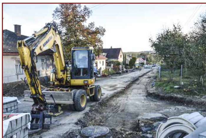
▲ Rekonstrukce komunikace Rašínova. Foto: Michael Omes
