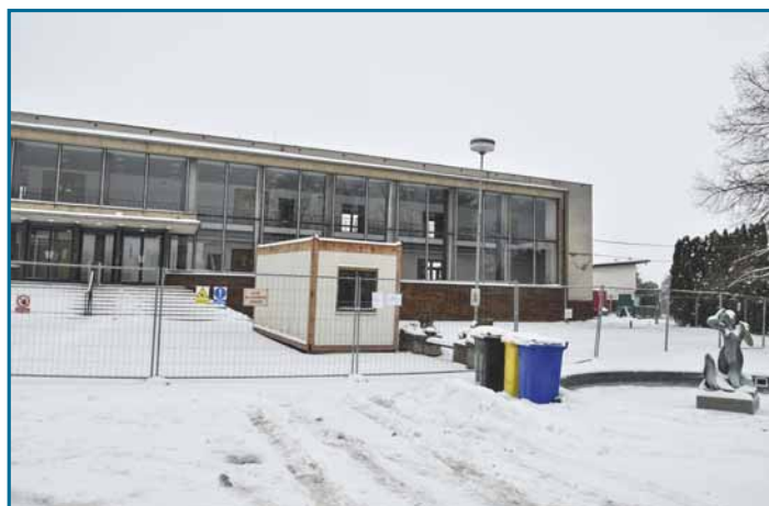
▲ Rekonstrukce kulturního domu byla zahájena. Foto: Michael Omes
