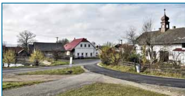
▲ Opravené povrchy komunikací na návsi ve Hřístích. Foto: Michael Omes
