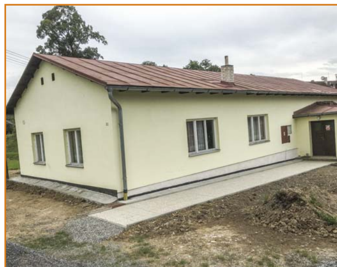
▲ Kulturní dům v Utíně po rekonstrukci Foto: Michael Omes
