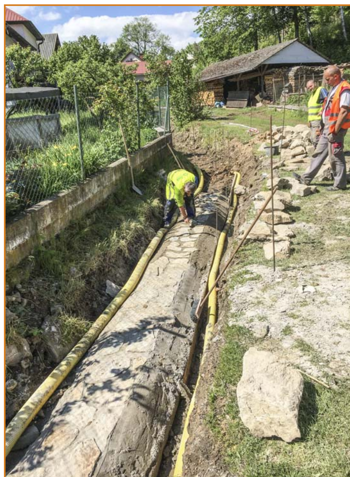
▲ Česká Jablonná - oprava vodoteče. Foto: Michael Omes
