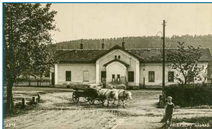
▲ Původní nádražní budova železniční stanice Příbyslav
