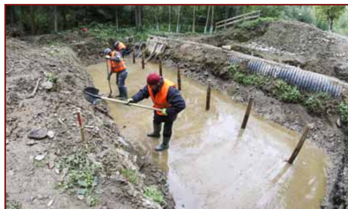
▲ Ze všeho nejdříve dělníci museli odčerpávat vodu, potom se již pustili do betonáže patek pilířů mostu.
