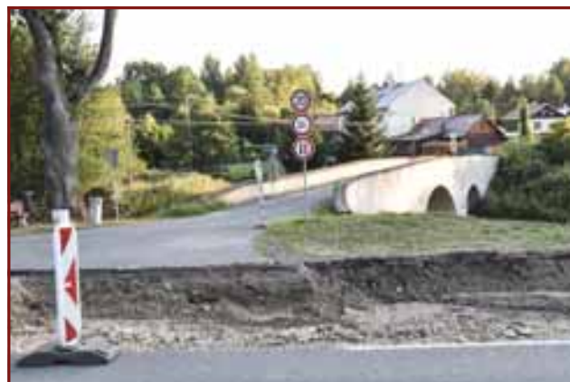
▲ Rekonstrukce komunikace I/19 v Ronově nad Sázavou. Foto Michael Omes
