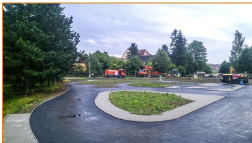
▲ Budování dopravního hřiště v Ronovské ulici 14. 7. 2016, foto Michael Omes
