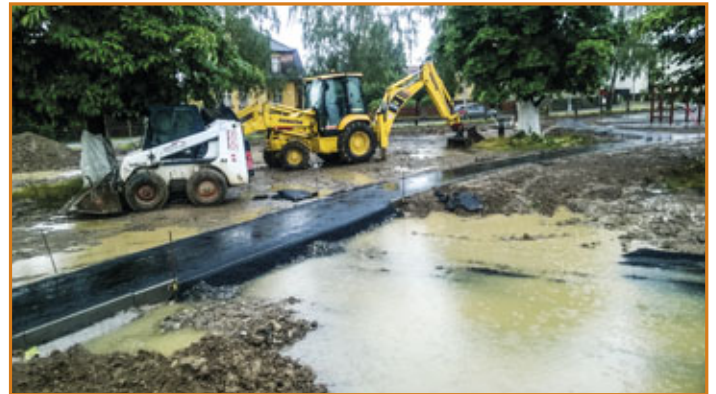
▲ Budování dopravního hřiště v Ronovské ulici 14. 7. 2016, foto Michael Omes
