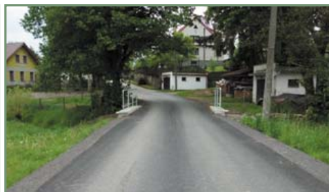
▲ Oprava propustu a komunikace
