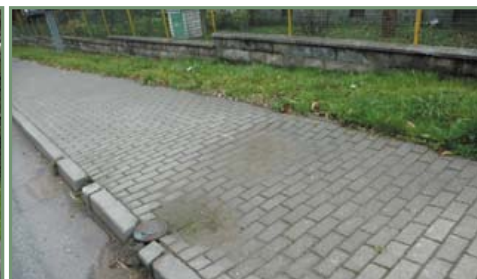
▲ Oprava chodníku na ul. Hesovská
