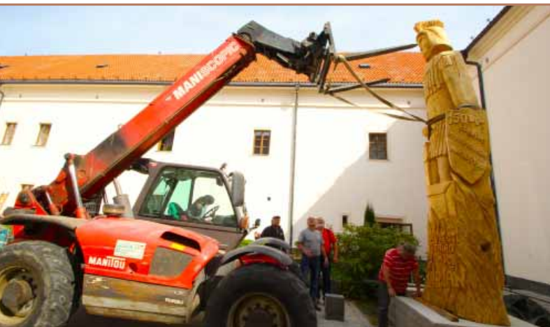
▲ Dát na betonový podstavec šest metrů vysoký opracovaný kmen nebylo snadné. Pomohl stroj na zvedání těžkých balíků slámy Manitou z přibyslavského podniku Osiva.
