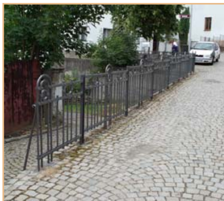
▲ Renovace nátěru zábradlí Vyšehrad
