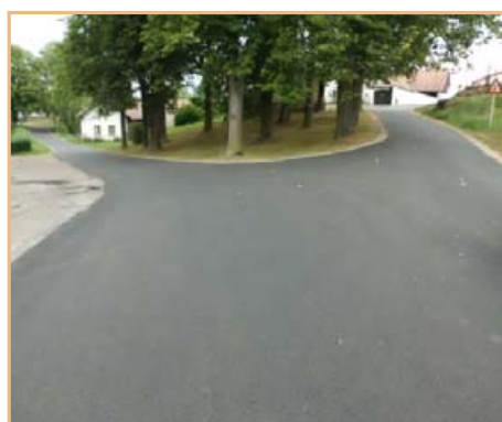
▲ Rekonstrukce komunikace Česká Jablonná
