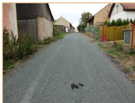
▲ Rekonstrukce komunikace Keřkov
