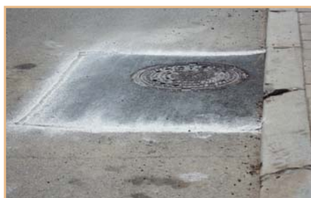
▲ Oprava kanalizační šachty v ul. Niklfeldova
