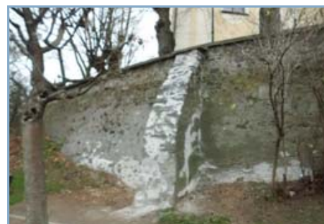
▲ Oprava zdi u kostela
