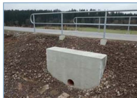
▲ Opravený proustek na cyklostezce
