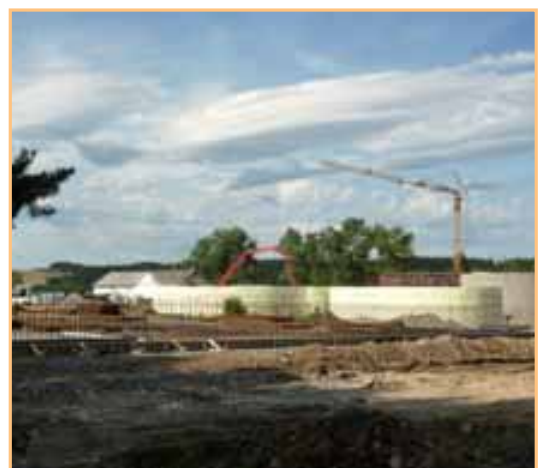
▲ Výstavba bioplynové stanice
