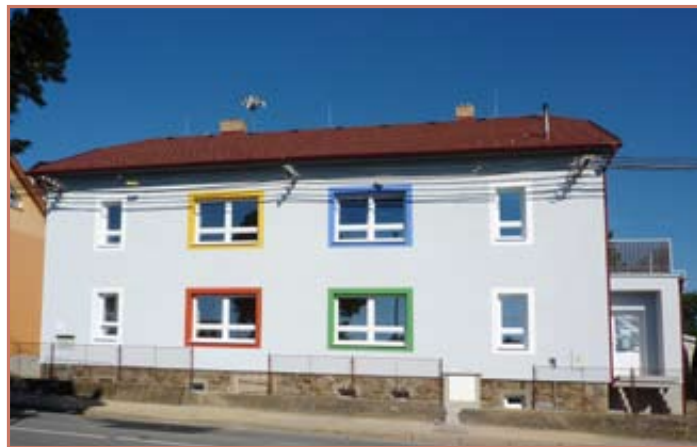
▲ Mateřská škola – Tyršova 242, stav v září 2012
