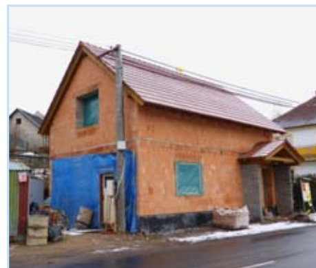
Stavba hasičské zbrojnice v Dobré
