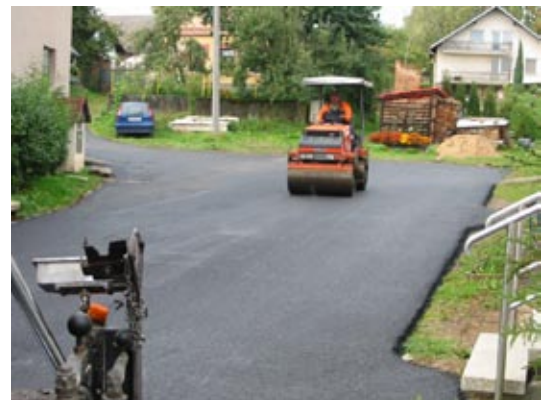
▲ Oprava komunikace u Pochtiolů
