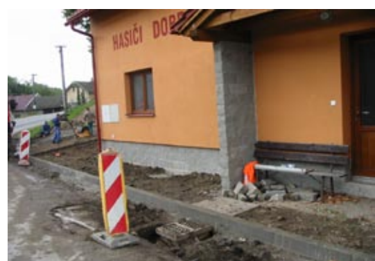
▲ Stavební úpravy vjezdu hasičské techniky v Dobré
