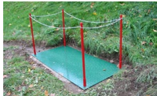
▲ Zabezpečení rozvodu v Dolní Jablonně
