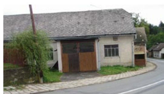
▲ Nově položený povrch chodníku v Dobré
